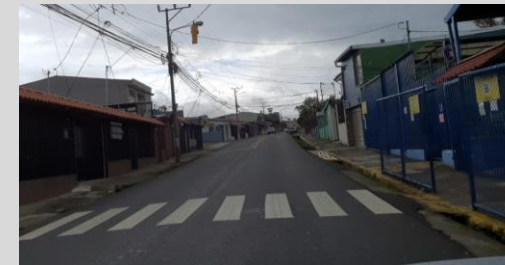
Las rampas y semáforos existentes están en las cercanías de las escuelas, CEN CINA, instituciones y universidades.
