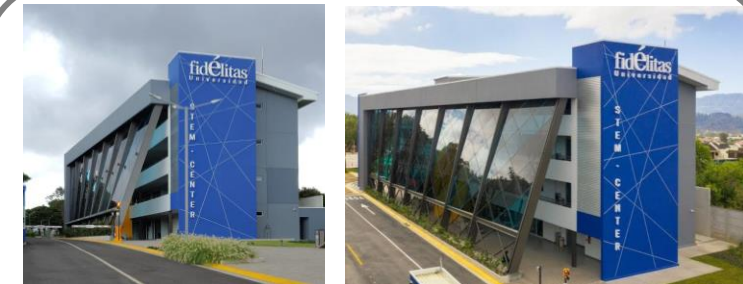
Edificio nuevo Universidad Fidelitas: Edificio para impartir los posgrados, cuenta con modernos laboratorios y alta tecnología.
