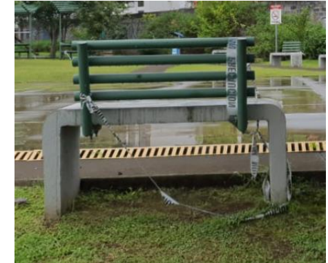
Tipo de bancas con bancas existente en los parques
